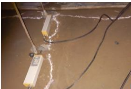
图 20 纵向裂缝
